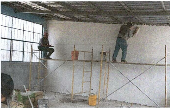
Foto 3: Reparación de repello y cernido de paredes.
