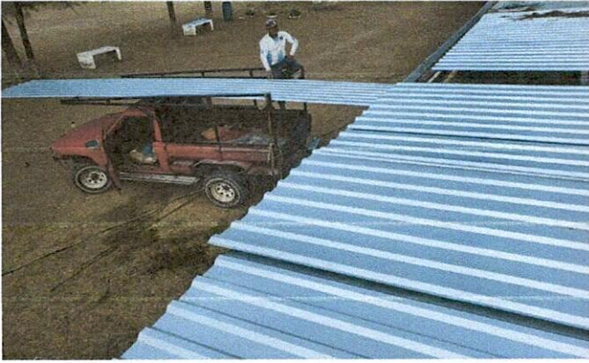
Foto 1: Mejoramiento y sustición de cubierto de lamina.
