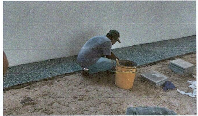
Foto 2: Mejoramiento y sustitución de piso.
