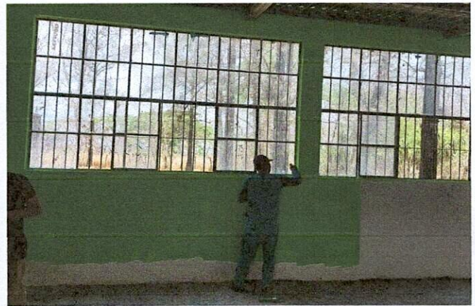
Foto 4: Pintado de paredes
